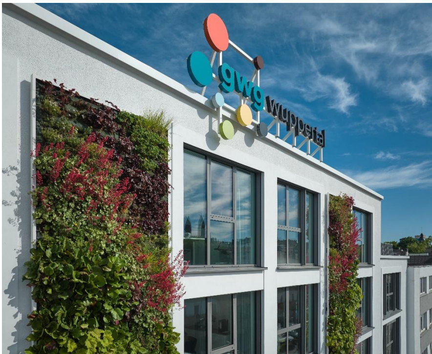
gwg-Geschäftsgebäude in Elberfeld (Foto: Sigurd Steinprinz)
