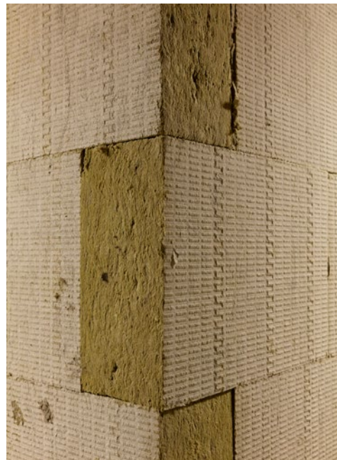
Neuerungen im Fokus: digitale Klingelanlage mit Paketboxen, Wärmedämmung auf Effizienzhaus-55-Standard und Lüftungsanlage mit Wärmerückgewinnung.
