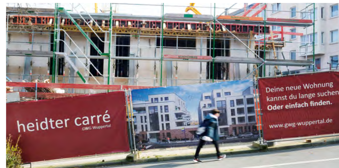
Der Baufortschritt des heidter carrés.
